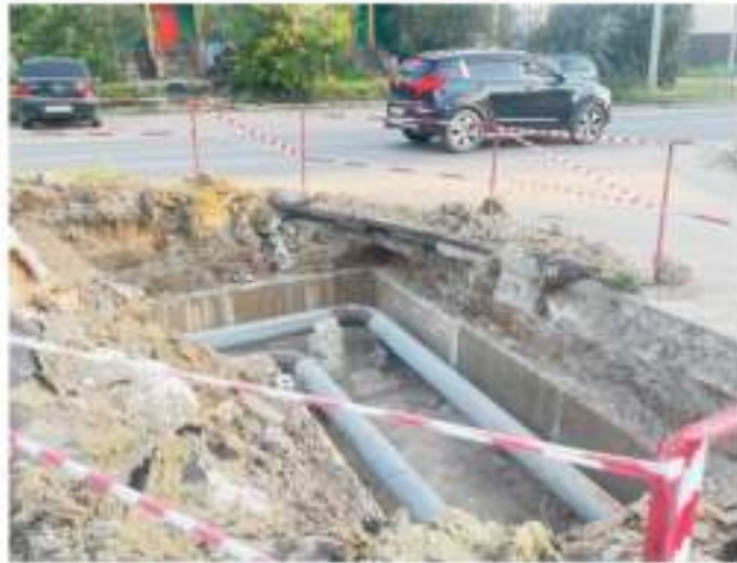
На фото: ремонтная кампания в июле 2024 года
