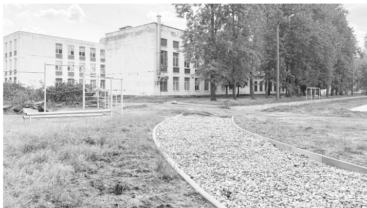
Ход работ по благоустройству стадиона СОШ №3 г. Конаково
