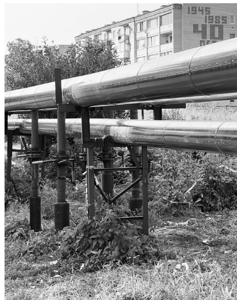
Капитальный ремонт тепловой изоляции магистральной тепловой сети в п. Козлово
