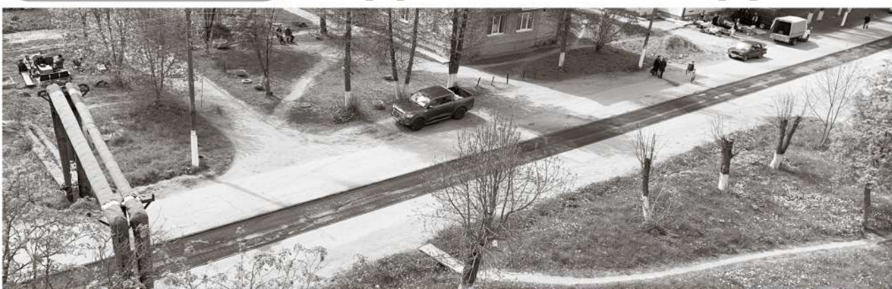
Полным ходом идут работы по улице Пионерская поселка Изоплит. Здесь отремонтируют 0,65 км дороги на общую сумму 7 053 994 руб.
