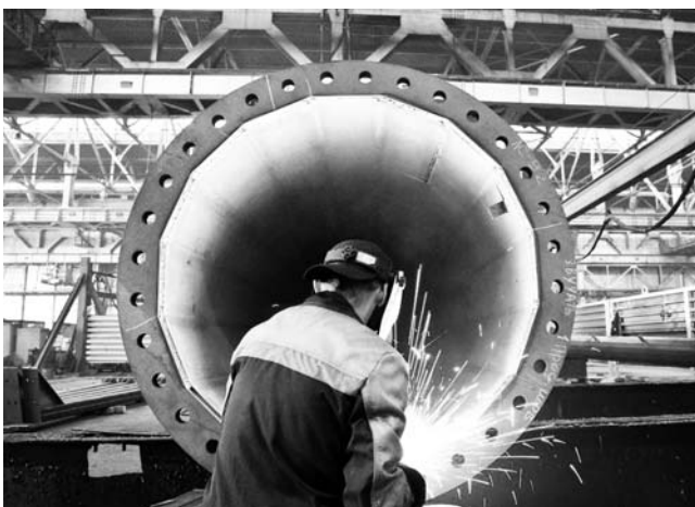
Сварка секции многогранной опоры в ЦСКиП
